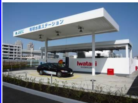
液化水素ステーションの例 (有明ステーション)
