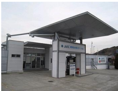
【水素ステーション】
