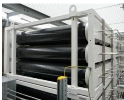
クロムモリブデン鋼使用蓄圧器 (海外使用例)
